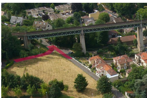
Zone coupée à la circulation piétonne et routière - Vauillons
